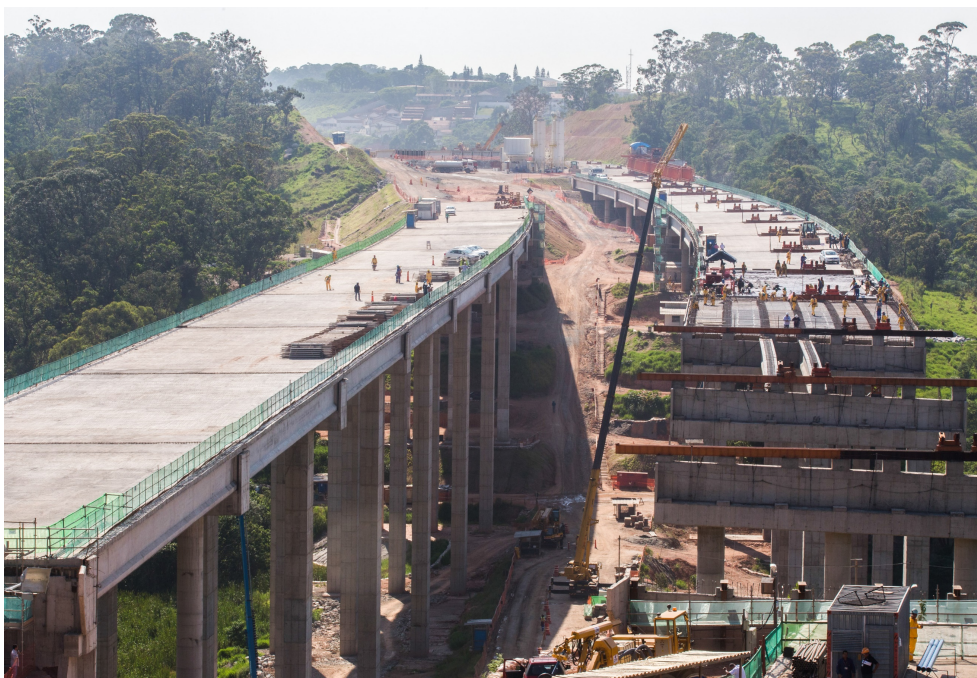
Figura 4.2 – Execução de Obras de Arte Especiais (Portal do Governo, 2015)
